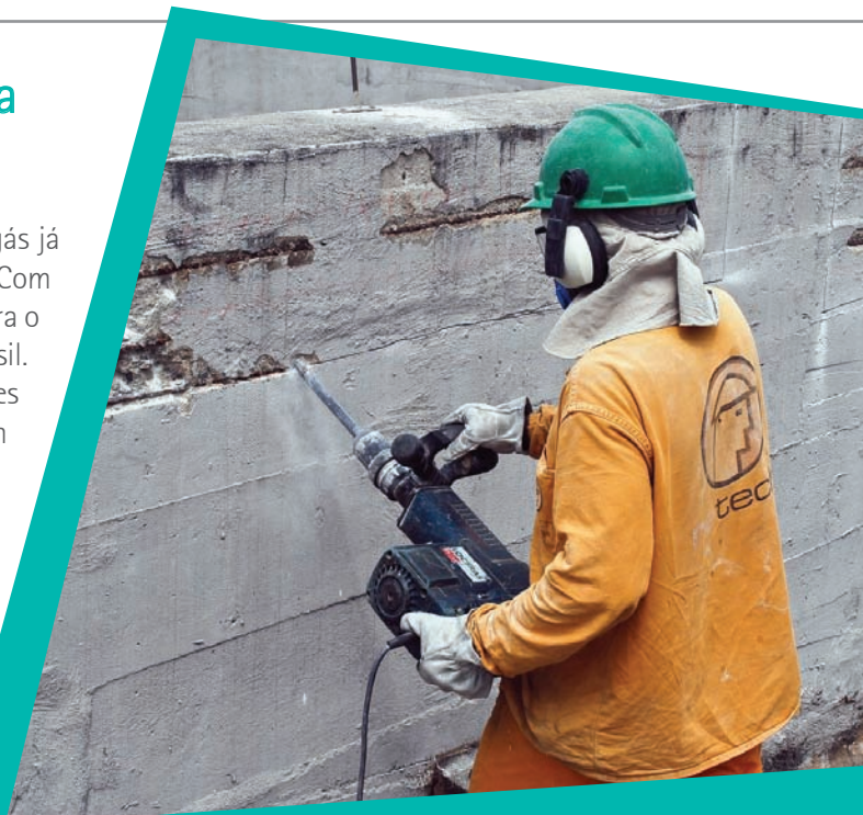
Nas fotos, destaque para os equipamentos da Locbras, utilizados em grandes obras realizadas país a fora, como a reforma do Mineirão para a Copa do Mundo de 2014 e a construção da Cidade Administrativa de BH
